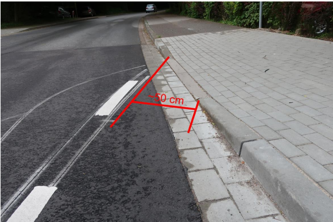
Abb. 10: Zu schmale Auffahrt am Ende des Schutzstreifens, obere Seite des Kreisverkehrs (Munketoft).
