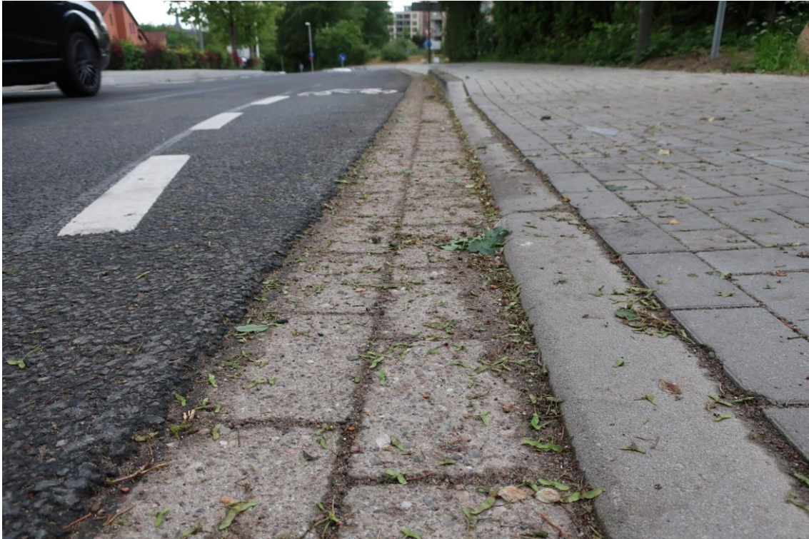
Abb. 13: Absätze am Anfang der Einfädelspur, obere Seite des Kreisverkehrs (Munketoft).
