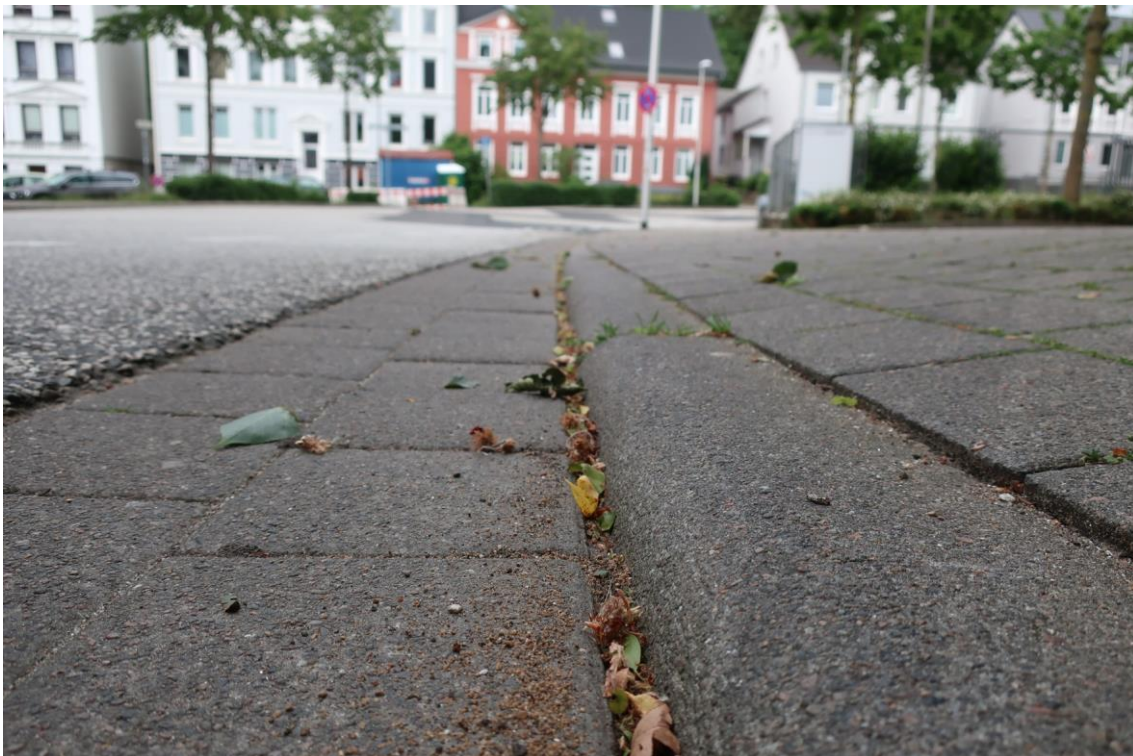
Abb. 8: Stufe am Übergang Mühlendamm / Munketoft.
